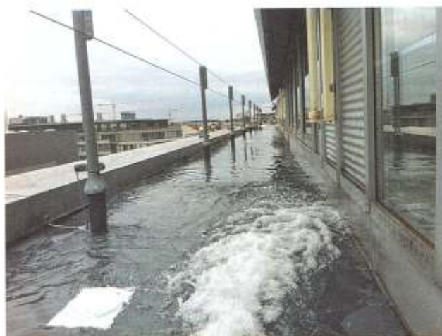
Bild 4. Das Dach wird geflutet, um die Dichtigkeit unter Beweis zu stellen (Fotos: RENOLIT)
