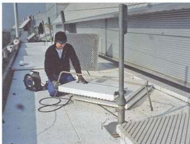
Bild 2. Die zusätzliche Wärmedämmung SecuTherm wird zugeschnitten
