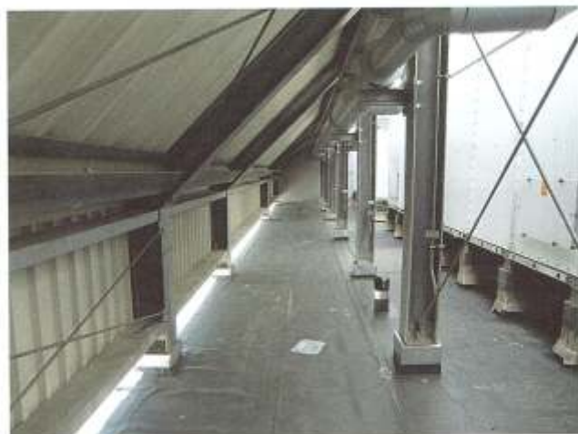
Bild 3. Die neue Abdichtung aus ALKORTEC wurde fertig verlegt und die Dachfläche wird für die Flutung vorbereitet
