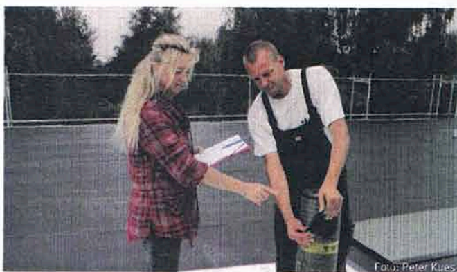
Annett Lange, Servicebereichsleiterin TFM Cottbus und Ralf-Udo Karan bei der Flachdachsanieierung
