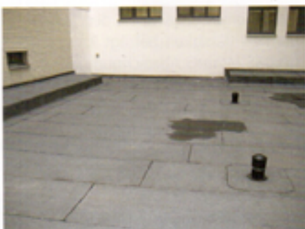
Hier wurde mit 2-Lagen Bitumen abgedichtet. 1. Lage, kalt-selbstklebende Bahn 2. bit. beschieferte Oberlage Durch die zwei hier gesetzten Lüfter kann die Feuchtigkeit an die Atmosphäre abgeleitet werden.
