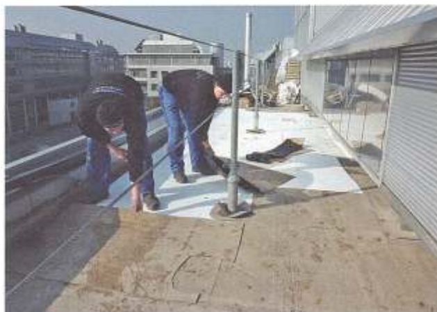
Bild 1. Die alte Abdichtung aus PVC-Dachbahnen wird in handliche Stücke zerschnitten und dem Recyclingsystem zugeführt
